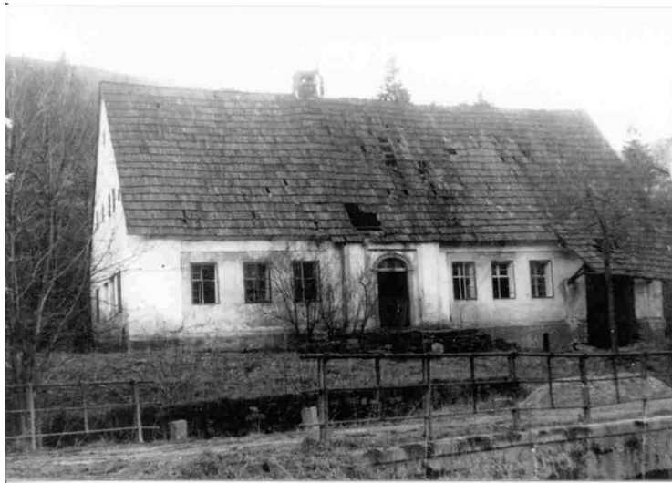
Obr.: Pohled na dům Bernharda Kutzeru těsně před demolicí kolem roku 1960
