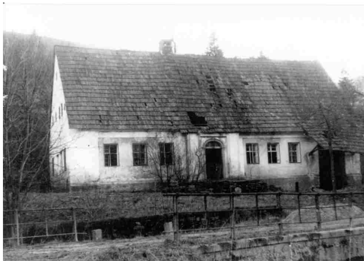
Obr.: Pohled na dům Bernarda Kutzera těsně před demolicí kolem roku 1960
